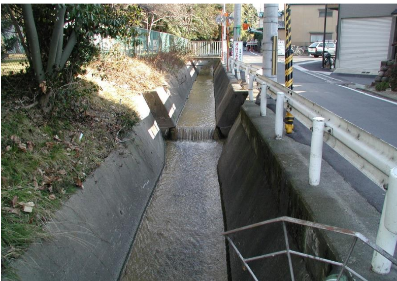
写真1 コンクリート三面張りとなった
