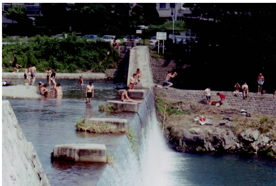
写真 8 暮しに溶け込んだ「土木」(柊野砂防堰堤)
