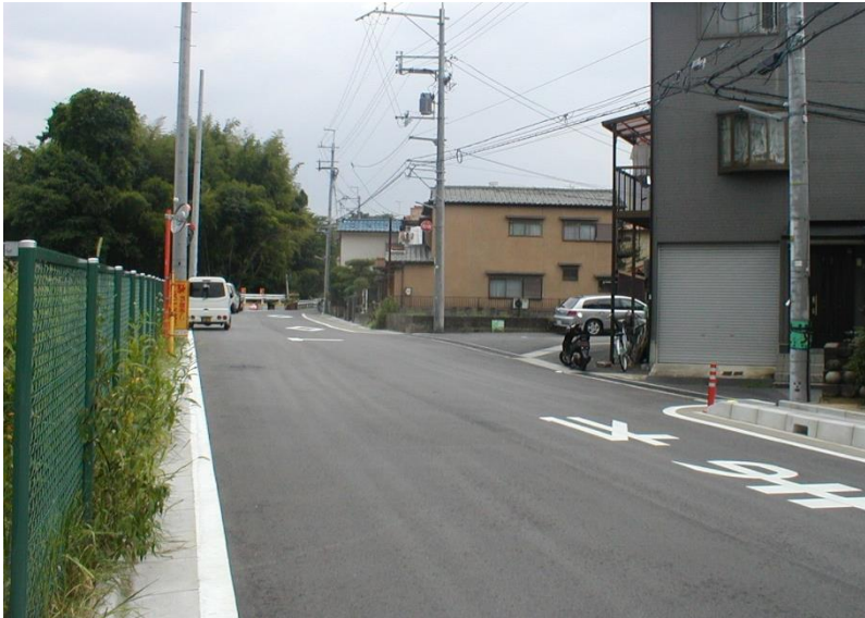
写真 2 暗渠化された折居川（同
